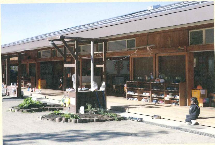
保育室の前にある小さな花壇の脇に、雨水タンクを設置。園舎の屋根からつないだ管を通して、木枠で囲ったタンクに貯まるシステムだ。
